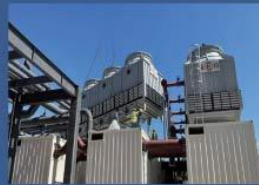
流程6—现场安装调试
