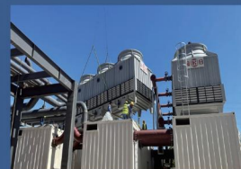
流程6—现场安装调试
