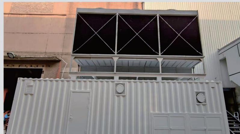
上海柴油机股份集装箱式冷源模块 完成时间：2021年
